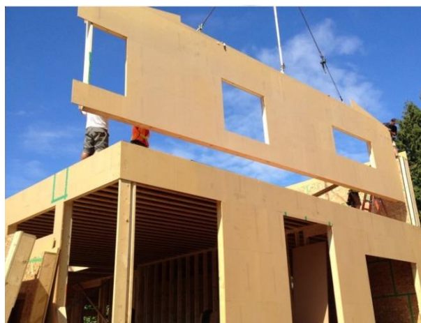
Рисунок 2 – Монтаж плит перекриття та стін із CLT – панелей
