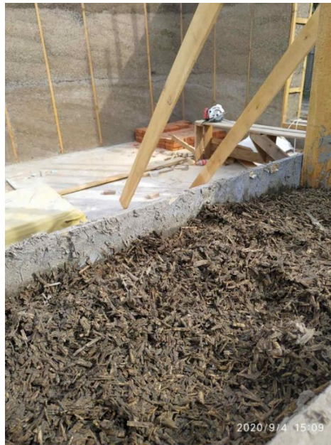
Рисунок 1 Зведення приватного будинку з костробетону (м. Харків, вересень 2020 р.)
