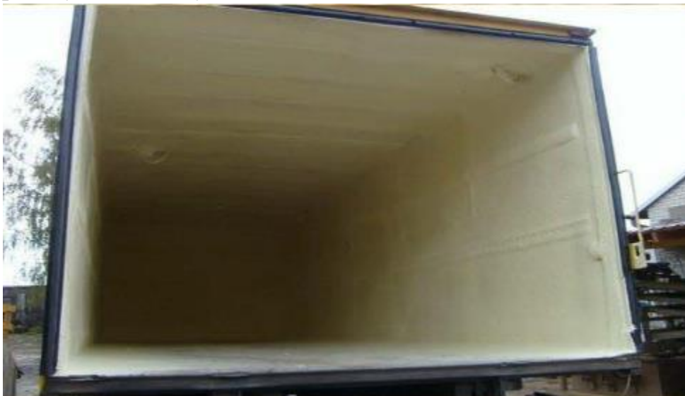
Рисунок 1 - Приклад нанесення пінополіуретану на внутрішні поверхні причепа
